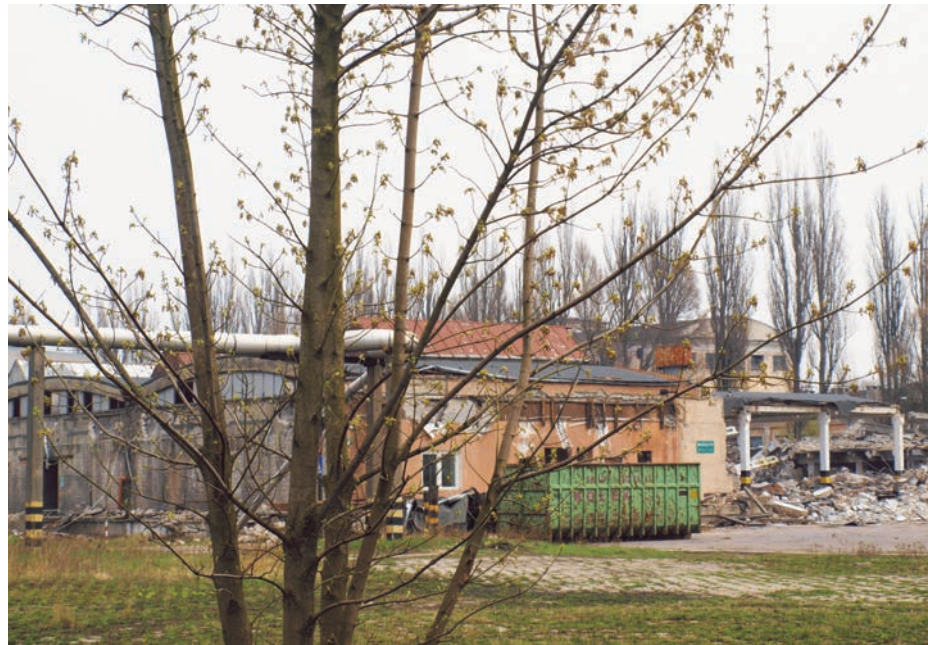
Rozpoczęła się rozbiórka części budynków papierni
