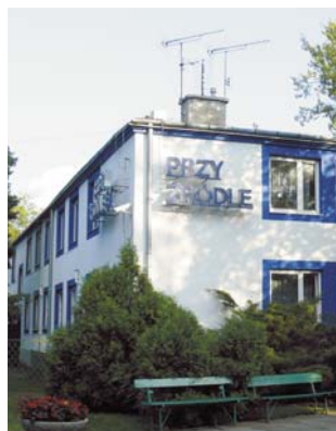
Prace przy budowie centrum hydroterapii, które ma stanąć w miejscu sanatorium Przy Źródle, miały się rozpocząć w połowie roku. Jest listopad i nic się nie dzieje
